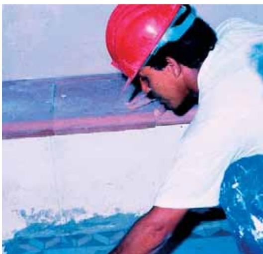
первичного соприкосновения самого связующего слоя с плитками. Когда плитка накладывается на поверхность клея и придавливается, границы таких участков вдавливаются и расширяются, затрагивая большую часть обратной стороны плитки. Данный эффект можно проверить,
